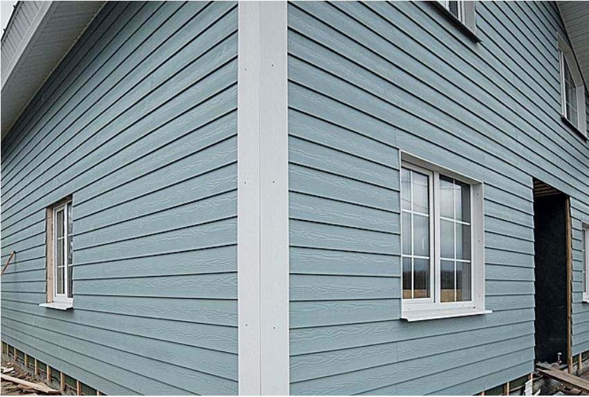
Рис. 11. Облицовка жилого дома фиброцементным сайдингом
